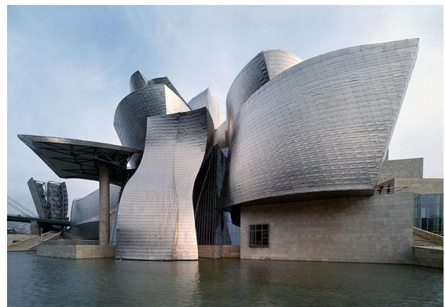
Fig. 3 Guggenheim Museum Bilbao, Frank Gehry, 1991-1997
